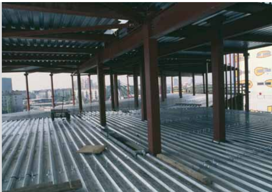
Disposición de conectores en planta intermedia
