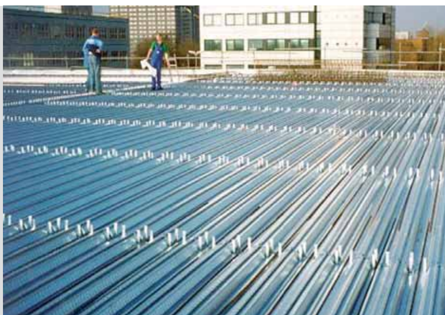
Vista general de los conectores colocados
