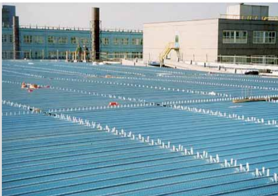
Finalización de la colocación de los conectores
